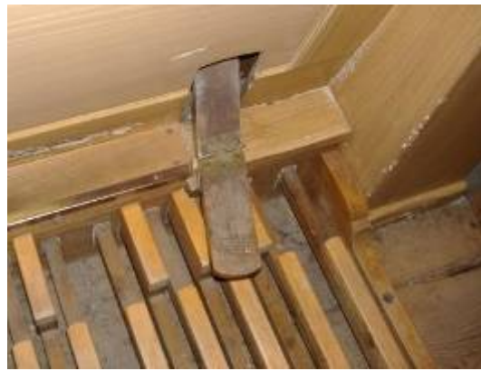
42–43. kép: 342 A szélcsatornába benyúló rézlap és az irányítására szolgáló billenőtalp
