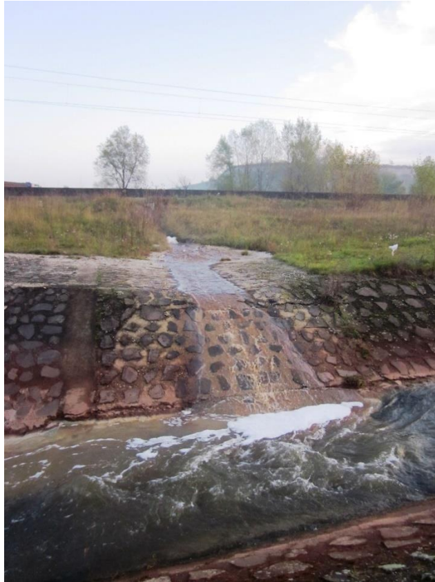
7. kép: A vörösiszap tározók melletti árkokból semlegesítés után átszivattyúzott szennyvíz (Kolontár, 2011.10.20.)
