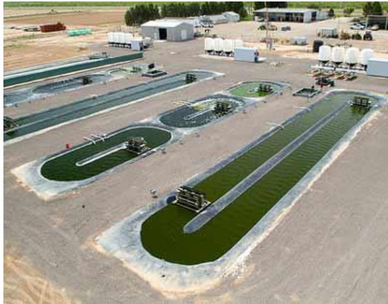
7. ábra A leggyakrabban alkalmazott szabadtéri rendszer a „Raceway” medence [61]
