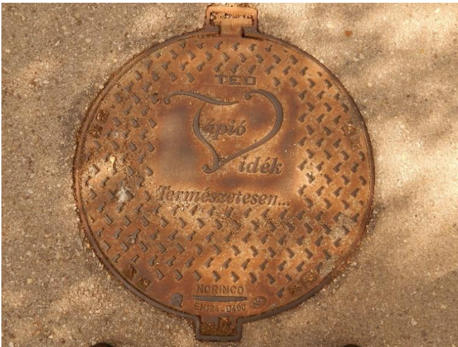
73. ábra. Egyedileg kialakított csatorna fedlap a Tápió-vidék logójával. (Saját fénykép)
