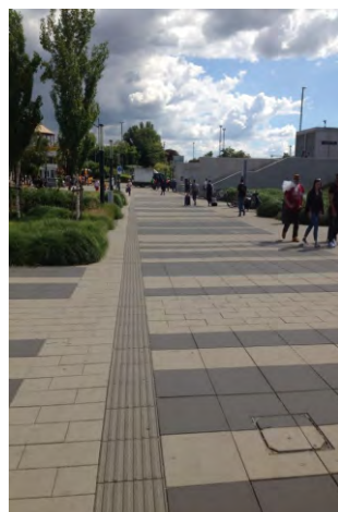
249-251. közlekedési csomópontban gondosan tervezett, orientáló burkolatminta és abba ízesülő taktilis jelzésrendszer
