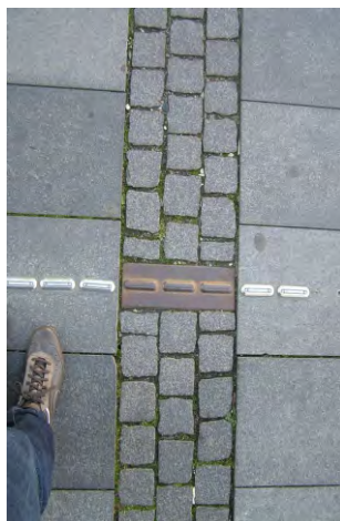
242-245. terméskő burkolatba integrált egyedi taktilis jelzésrendszer; egy vezetőborda nem érzékelhető; a fenntartás hiánya
