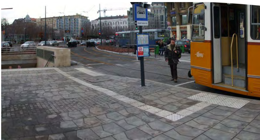
464. a zónahatár-jelzés később jött - csak az első ajtó helyét volt szükséges jelölni
