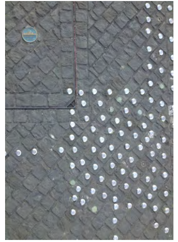
470-472. figyelmeztetőjelzés villamosperonon - hibás koncepció (ld. 468-469.); az elemeket nem pótolják; kiskockakőben nem érzékelhető
