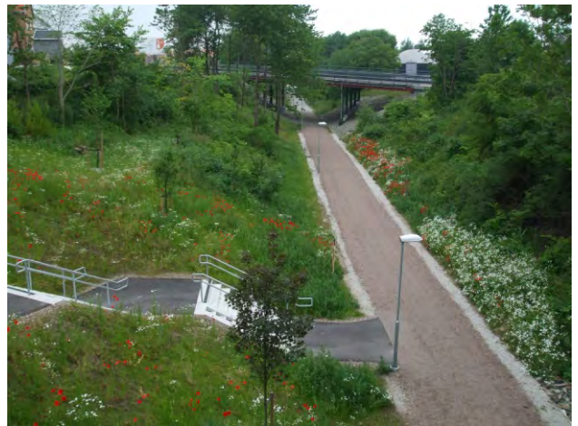
523. jól karbantartott kerékpárút stabilizált burkolaton
