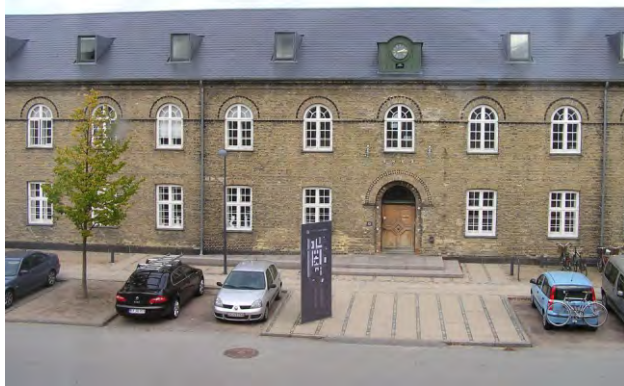
95. utólagos, a környezetbe simuló akadálymentesítés
