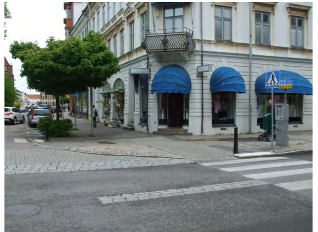
324-325. a látássérültek a süllyesztett szegélyt nem érzékelik, mégis a kiemelt szegély van taktilis figyelmeztetésávvá jelezve
