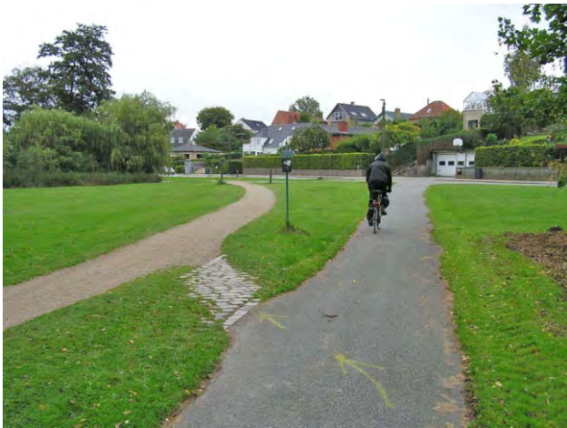
524. a gyalogút stabilizált, a kerékpárút aszfalt burkolatú
