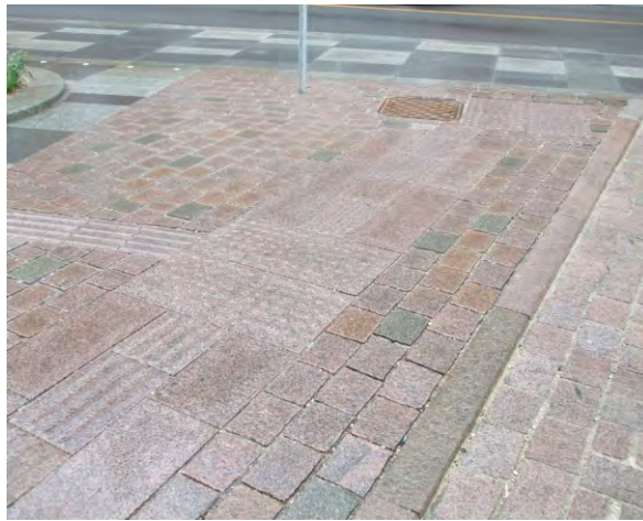
342-343. a járdaburkolathoz illő egyedi taktilis jelzésrendszer; vizuális kontraszt az útburkolaton sincs 344. rendhagyó dizájnban megfér
