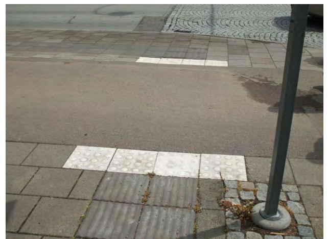
326-327. lépésszélességnél keskenyebb figyelmeztetősáv; a vezetés nem színkontrasztos, csak a figyelmeztetés
