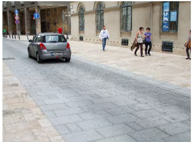
142-143. azonos szinten levő, eltérő forgalmi zónáknál fontos a kontraszt (a látássérültek és a vakvezető kutyák nehezen vagy nem érzékelik)
