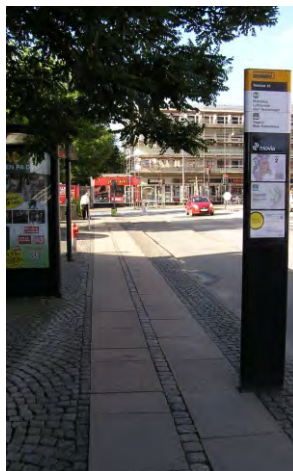
450-452. a járdán kialakított, színében nem kontrasztos TWSI figyelmeztetőjelzés mutatja az első ajtó helyét; a kerékpárosok figyelnek
