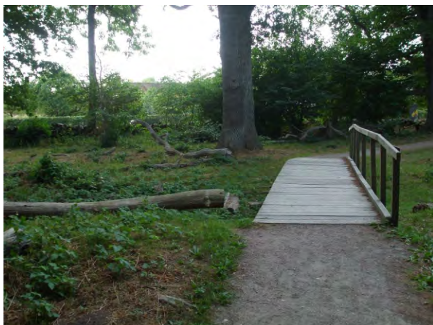
674-675. a mindkét oldalon szintben csatlakozó híd alkalmas az akadálymentes használatra; balesetveszélyes helyen leesésvédelem
