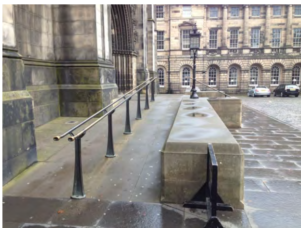
97-98. utólagos, a környezetbe simuló akadálymentesítés alternatív útvonalakkal (lépcső, korláttal kísért rámpa, korlát nélküli rámpa)
