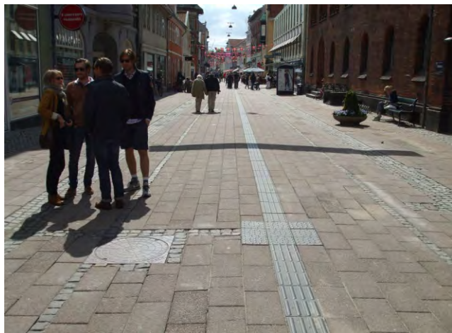
246-248. a taktilis jelzések integrálódnak a járófelületeken egyébként alkalmazott burkolati mintába
