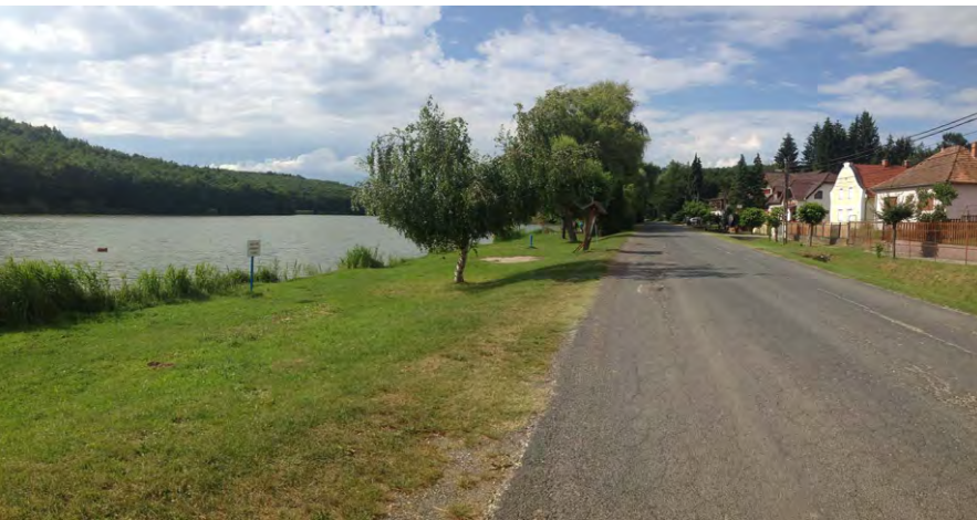
549. az autót aszfalt burkolata a parkot is kiszolgálja
