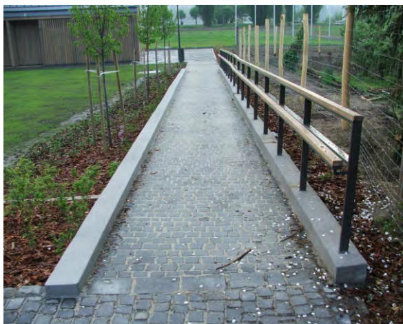
78-80. akadálymentes rámpa szolgál a lépcső (ld.56-57.) alternatívájaként, kerékvágyó és duplasoros korlát, amelyen a kéz nem akad meg
