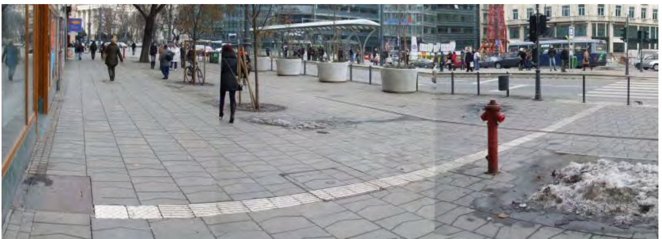
289. az átkelő megtalálásának érdekében a rávezetősáv a járda teljes szélességében húzódik (ma már visszafogottabb az alkalmazás)
