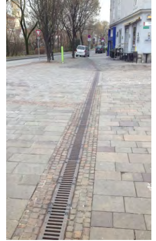
205-207. a vonalas vízvezető rácsokat sok látássérült ember használja természetes vezetősávként (rácsköz &lt; 2cm)
