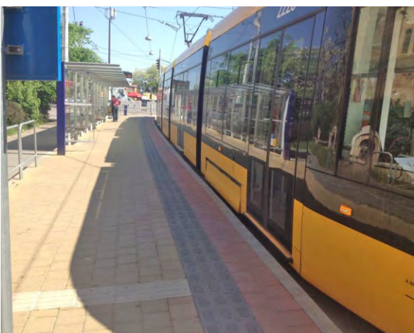
479-481. első ajtó és zónahatár jelölése az Ecseri úton; a villamosperon és a csatlakozó átkelőhely esetében is TWSI-rendszer telepített
