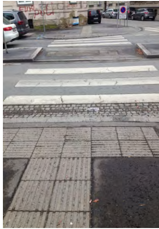
386-388. különböző burkolati arculatoknál ugyanazt a TWSI-rendszert alkalmazzák; keresztben álló vezetőjelzés figyelmeztető funkcióban
