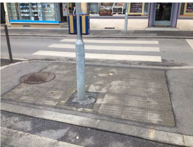
384-385. az átkelők kialakítása következetesen ugyanolyan; csak ott alkalmaznak TWSI-t, ahol nincsen természetes orientáló elem
