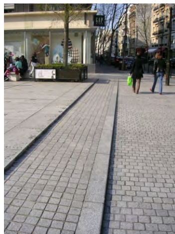
69-70. figyelmeztetőjelzés szélessége az érzékelhetőséghez min. 60cm
