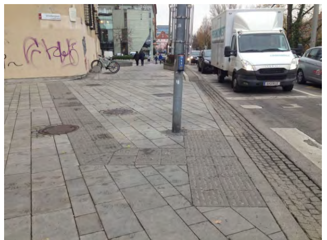
384-385. az átkelők kialakítása következetesen ugyanolyan; csak ott alkalmaznak TWSI-t, ahol nincsen természetes orientáló elem
