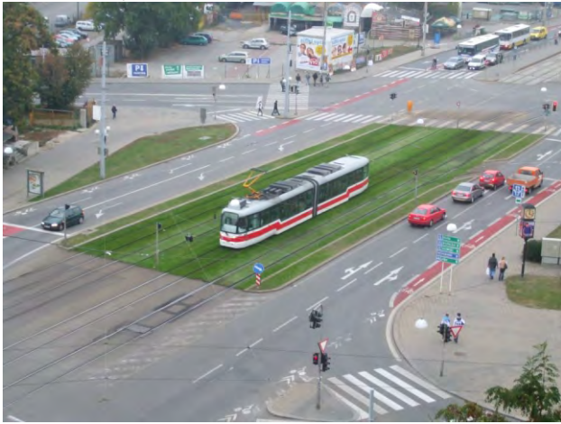
125. burkolatváltással elkülönített forgalmi sávok
