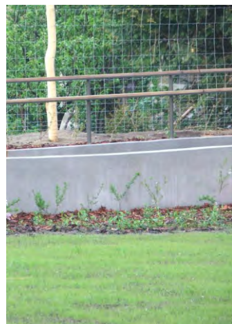
78-80. akadálymentes rámpa szolgál a lépcső (ld.56-57.) alternatívájaként, kerékvágyó és duplasoros korlát, amelyen a kéz nem akad meg
