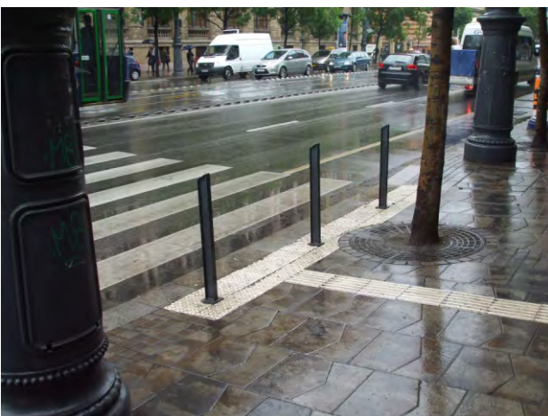
282-283. rávezetés a járda teljes szélességében; a fa elég messze van a vezetősávtól, de a pollerek a figyelmeztetősávban hegyesek
