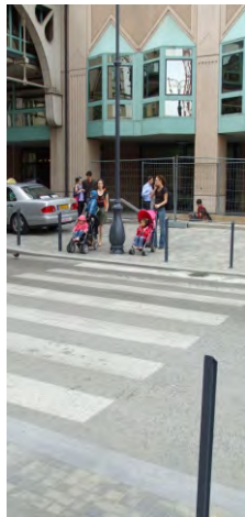
271-272. hiányzó taktilis jelzésrendszer pótlása
