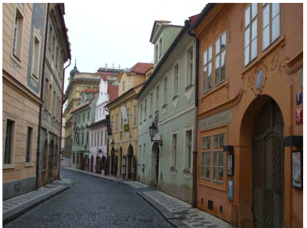
132. burkolatváltással elkülönített forgalmi sávok, a járda keskeny
