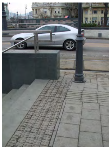
73-75. különböző taktilis jelzésrendszerek lépcső jelölésére a közelmúltban megújult budapesti közterületeken (2010, 2012, 2014)
