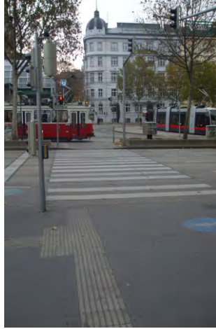
366-368. csekély szinkontrasztú TWSI Bécsben; figyelmeztetéskeresztbe fordított vezetőelemekkel
