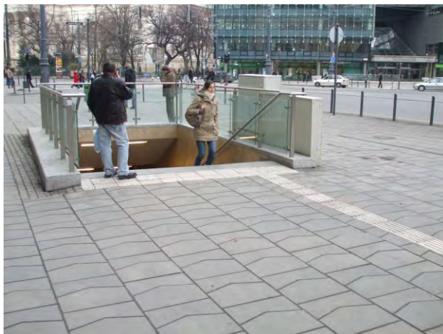
71-72. pótlott taktilis jelzésrendszer (kivitelezéskor a lépcső felső peremén több bottásveszélyes akadály, veszélyes építési terület)
