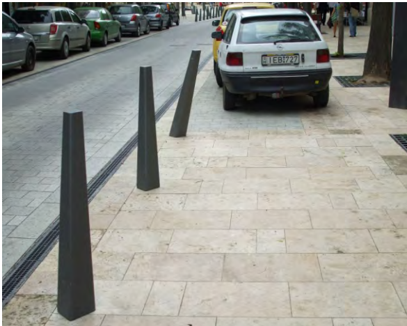
398-400. Pest új főutcájában a pollerek dőlési iránya esetleges (kivitelezési hiba), ami nehezíti a (párhuzamos) parkolást; fa takarja a táblát
