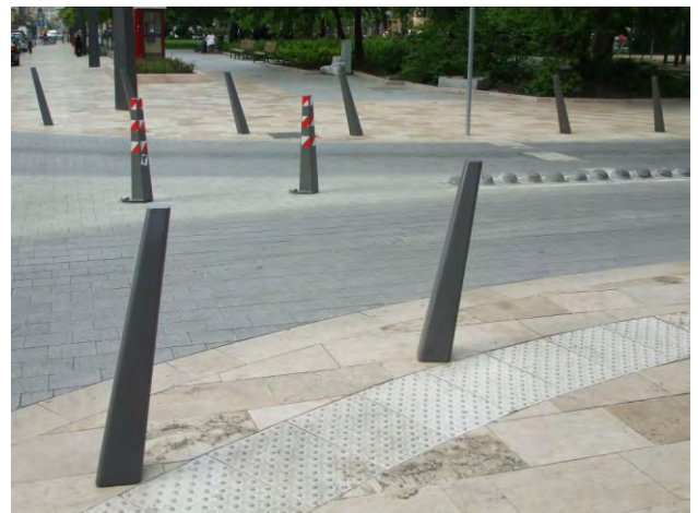
280-281. minden átkelőhelynél szükséges a figyelmeztetés (rávezetősáv csak a jelölt átkelőknél); a pollerek ferdesége balesetveszélyes
