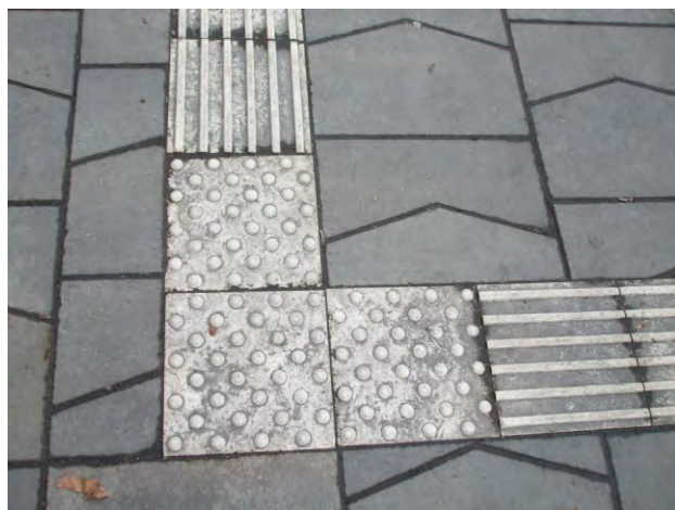
234-235. korábban a csomópontokban figyelmeztetőjelzés volt - ma már a vezetősáv megszakítása jelzi az irányváltásokat és célpontokat
