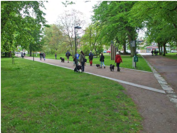
530-531. a stabilizált burkolattal kontrasztban van a szegély, ill. a kapcsolódó gyepfelület, amelyek természetes vezetőelemként szolgálnak
