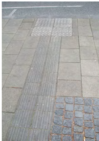
445-447. az első ajtó helye a burkolatban TWSI-vel jelezve; kerekesszékekkel is megközelíthető, és van elegendő hely a manőverezéshez
