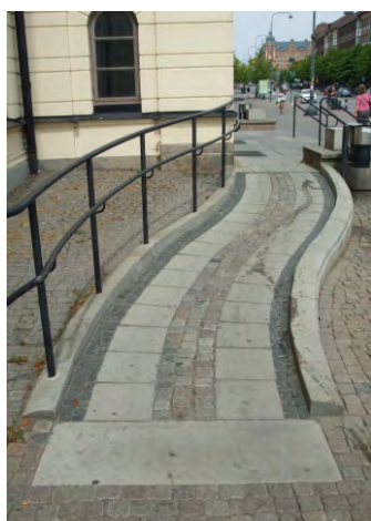
101-103. előlépcső és rámpa, a rámpa íves (kérdés: megfelelő-e a sugár-lejtés aránypár, vagy torzul a felület?), szíkontrasztos éljelölés
