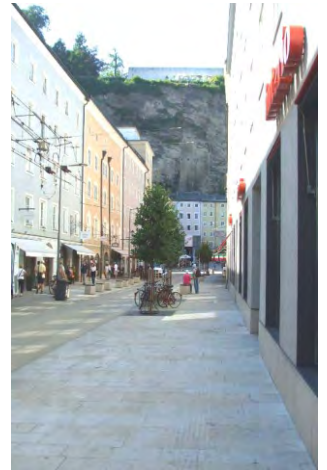
208-211. a burkolatba mart kialakítású vezetősáv nem érzékelhető, és kültérben hajlamos az eltömődésre; hiányzó szinkontraszt
