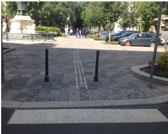
307-309. ...majd a rendszer átvált fémelemesbe, a Kossuth téri arculatnak megfelelően; a jelzésrendszer foghíjas, nincsen fenntartva
