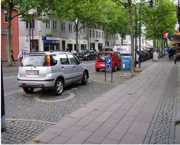
416-417. kiskockaköböl kirakott útburkolati jel akadálymentes parkolóban
