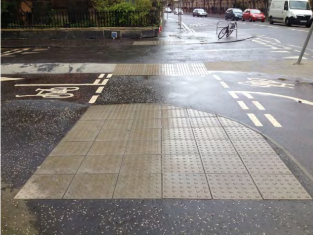
347-348. az átkelőhelyeket taktilis figyelmeztetősáv jelzi, rávezetés nincs, útburkolati felfestés nincs, a kerékpársáv is jelezve
