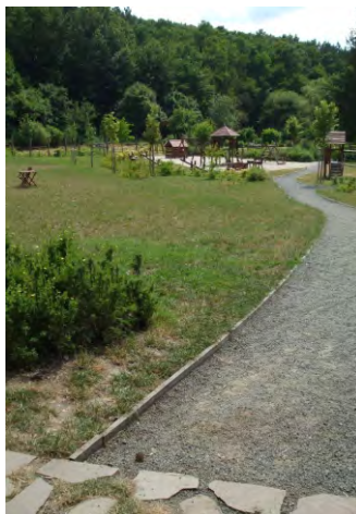
725-727. nagyobb frakciókat is tartalmazó, emiatt kerekesszéssel nehezebben használható stabilizált burkolatok
