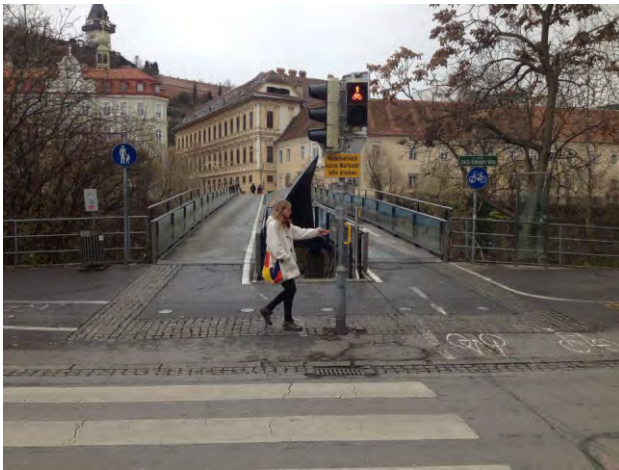
392. CWSM vezető- és figyelmeztetősáv gyalogátkelőnél
