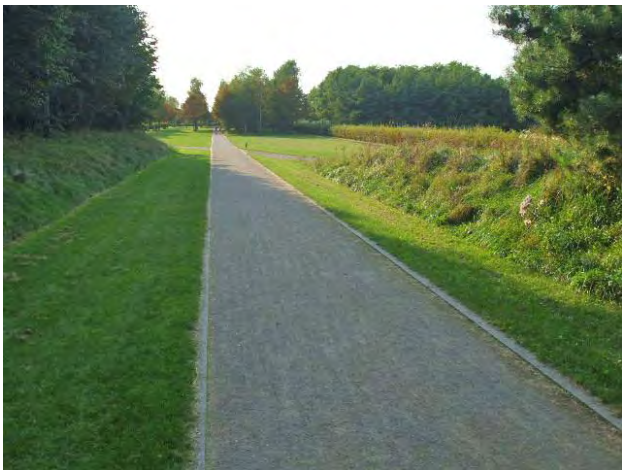
522. jól karbantartott kerékpárút stabilizált burkolaton
