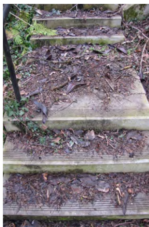
516-519. a lépcsőket kontrasztosan jelölni szükséges, ahol a leesés veszélye fennáll; a takarítás és fenntartás is nagy fontosságú
