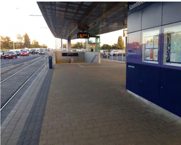
473-475. a zónahatár-jelzés először az 1-es villamos felújításakor jelent meg a peron biztonságos oldalának jelzésére
