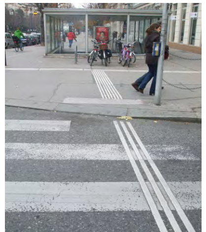
375-377. szinkontrasztos TWSI, csak vezetőelemekkel, az átvezetés magán az útpályán is adott (hazánkban ez nem terjedt el)
