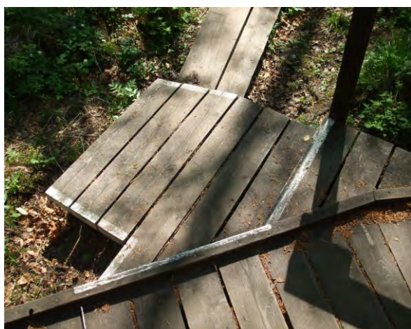
763-765. a bemutatóközponttól távolabb csökken a kiépítettség; a lépcsőéleket azért itt is kontrasztosan jelölték
