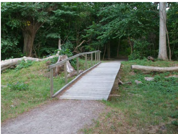
674-675. a mindkét oldalon szintben csatlakozó híd alkalmas az akadálymentes használatra; balesetveszélyes helyen leesésvédelem
