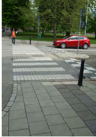
328-330. a figyelmeztetősáv az útburkolati jelekkel megegyező színű és szélességű; a vezetősáv csupán enyhe szinkontrasztot mutat
