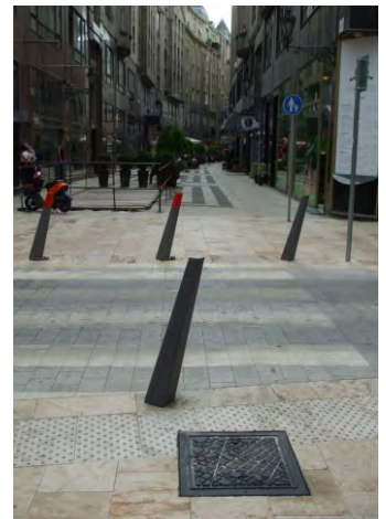
277-279. a figyelmeztetőelemek kialakítása lehetővé teszi az ívek kirakását; a ferde pollerek a közlekedés szelvényébe lógva veszélyesek
