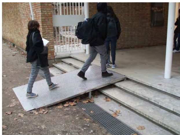
94. egyszerű kialakítású, utólagos rámpa előlépcső leküzdéséhez
