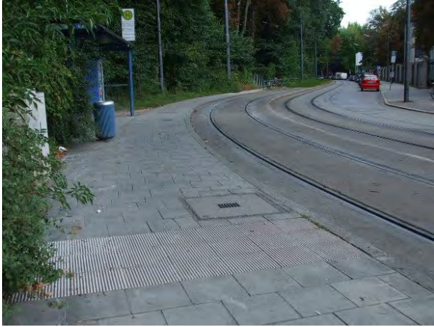
482. az első ajtó megtalálását eltérő érdességű burkolat segíti
