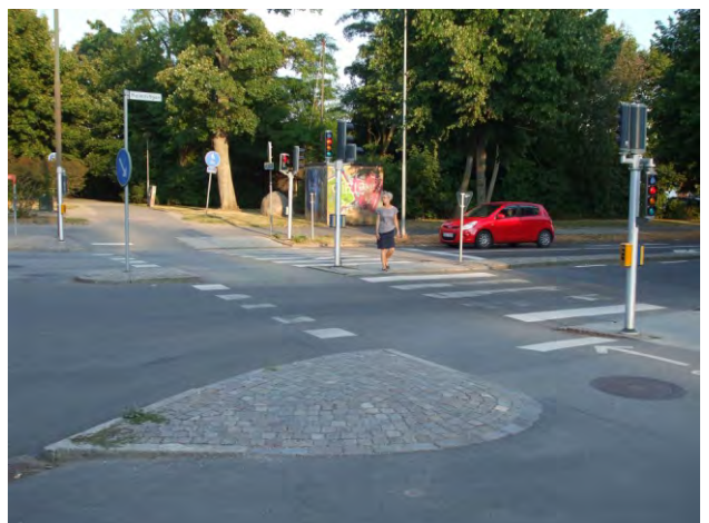
203-204. finom taktilis kontraszt orientál a teresedésben, ill. eltérő rakásmódú kiskockakő jelzi a forgalom holttereit
