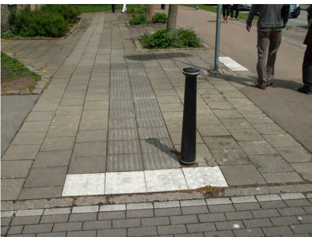
326-327. lépésszélességnél keskenyebb figyelmeztetősáv; a vezetés nem színkontrasztos, csak a figyelmeztetés
