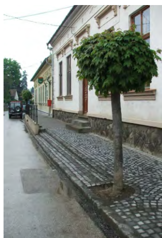
53-54. nem érzékelhető, balesetveszélyes lépcsős szegély / lépcső
