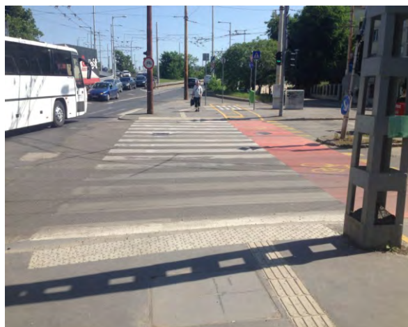
261-262. a fehér jelzés könnyen koszolódik, ezért a kontraszt megőrzése érdekében tisztítani kell
