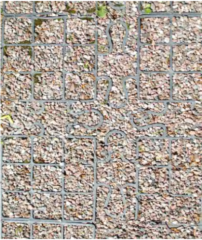
546-547. egyedileg megmunkált, fém kavicsfixáló rendszer
