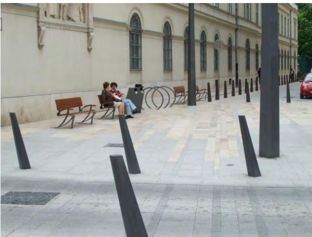
280-281. minden átkelőhelynél szükséges a figyelmeztetés (rávezetősáv csak a jelölt átkelőknél); a pollerek ferdesége balesetveszélyes
