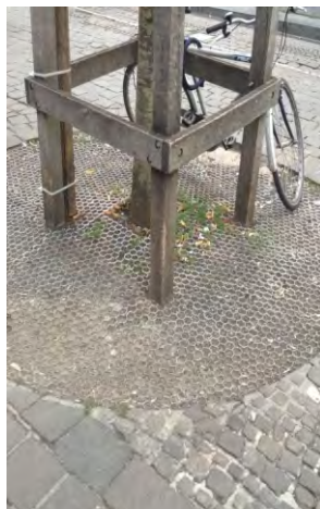
122-123. vízáteresztő, de járható burkolattal képzett favermek
