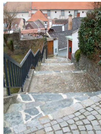
51-52. enyhe kontraszt a lépcsőfokok és a lépcsőpihenők burkolata között
