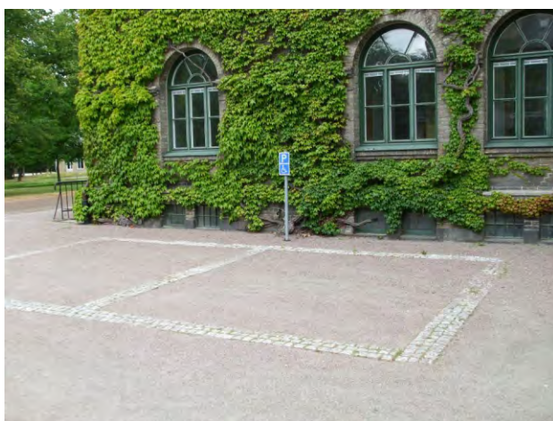
592. akadálymentes parkoló stabilizált burkolaton
