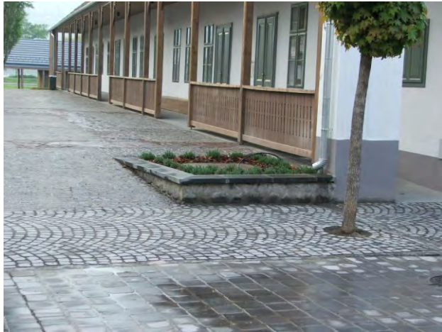
76-77. Történelmi város központja (esztétikum), az épület padlószintje és az utca közti szintkülönbséget a térburkolat finoman hidalja át
