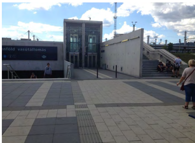
249-251. közlekedési csomópontban gondosan tervezett, orientáló burkolatminta és abba ízesülő taktilis jelzésrendszer
