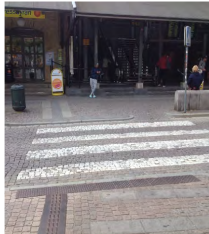
322-323. terméskő-burkolatba integrált fémelemes jelzésrendszer
