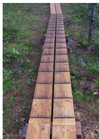
763-765. a bemutatóközponttól távolabb csökken a kiépítettség; a lépcsőéleket azért itt is kontrasztosan jelölték
