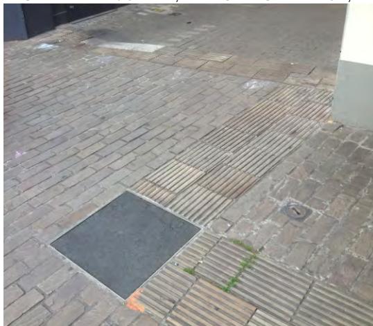
228-230. a Genben használt, csak taktilis kontrasztot nyújtó jelzésrendszer (a környező burkolat felületi érdessége szintén fokozott)
