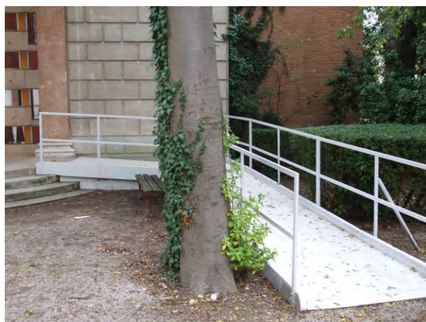
88-89. utólagos, mobil rámpával megoldott, az épület arcúthoz is illeszkedő akadálymentesítés
