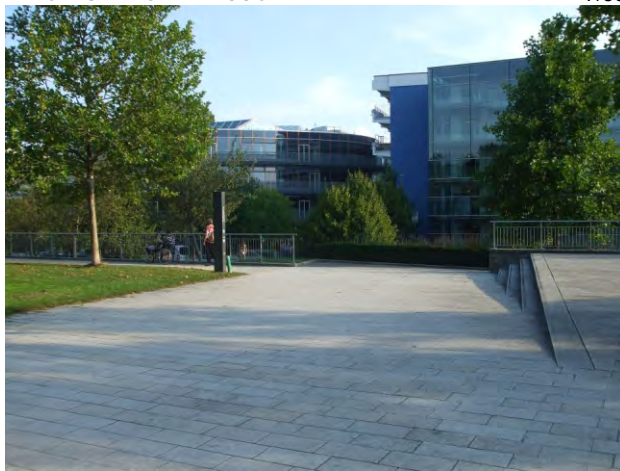
47. hiányzó kontrasztok, az éljelölés is elhalványult
