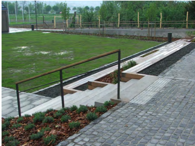
56-57. történelmi városközpont (esztétika), lépcsők két- és egyoldali, hasáb km. duplasoros kapaszkodóval, felül taktilis jelzés (keskeny)
