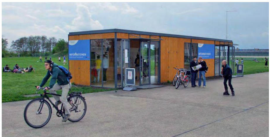
596. köztéri illemhely elhelyezésére is alkalmas épület közparkban
