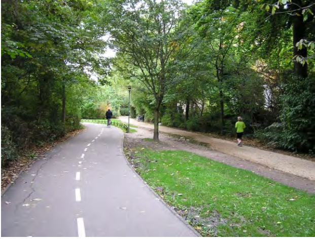
528. a gyalogút stabilizált, a kerékpárút aszfalt burkolatú
