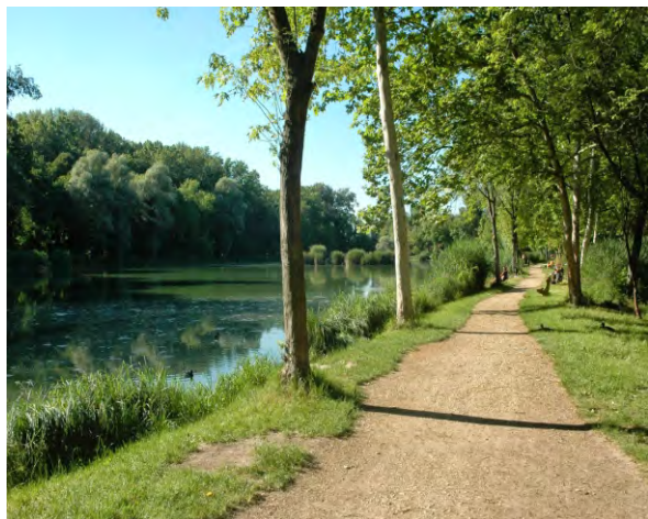
725-727. nagyobb frakciókat is tartalmazó, emiatt kerekesszéssel nehezebben használható stabilizált burkolatok
