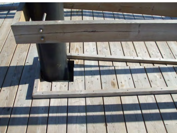
696-697. a kerekesszékkal való vízhez jutást segítő stég és rámpa kerékvetővel és korláttal ellátva; a hézagok keskenyek, megfelelőek
