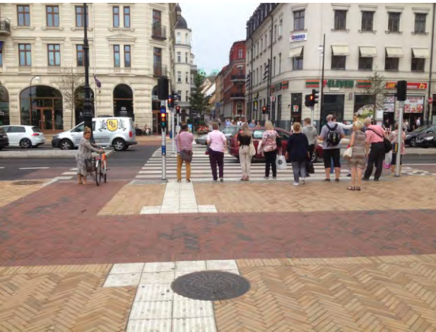
334-335. a megújított burkolat funkcionális jellegű: a különböző forgalmi sávok és funkciók vannak elkülönítve, konceptuális minta nincs
