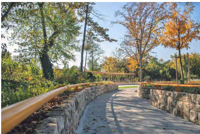
626-627. a tájékozódást kontrasztos korlátok és kapaszkodók is segítik
