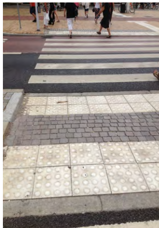
331-333. 2018-ra a figyelmeztetősávok lépéshossznyira szélesedtek; a vezetősáv olyan szélességű, hogy magán a jelzésen lehessen haladni
