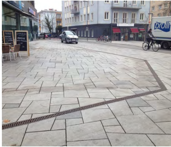
205-207. a vonalas vízvezető rácsokat sok látássérült ember használja természetes vezetősávként (rácsköz &lt; 2cm)
