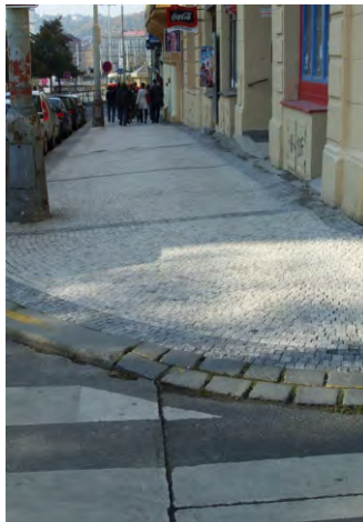
361-363. CWSM figyelmeztetőjelzések történeti környezetben - a taktilis jelrendszert próbálják az egységes burkolati brand-be integrálni
