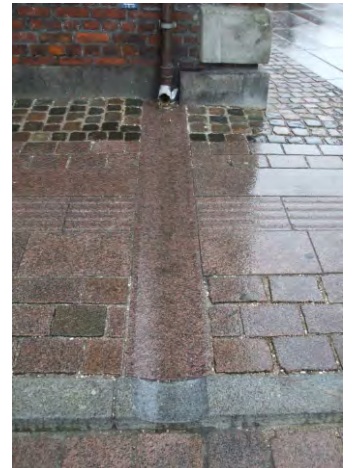
214-216. egyedi mesterséges taktilis jelzések egyedi terméskő burkolatban; mobil és rögzített akadályok a vezetősávon, fokozott veszély
