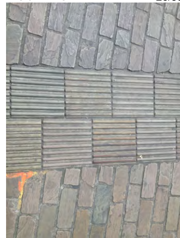
228-230. a Genben használt, csak taktilis kontrasztot nyújtó jelzésrendszer (a környező burkolat felületi érdessége szintén fokozott)
