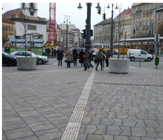
231-233. a kiskörűti egységes rendszerben elhelyezett vezetősávok a Kálvin téren; a vezetősáv mellett 80-80 cm-t szabadon kell hagyni
