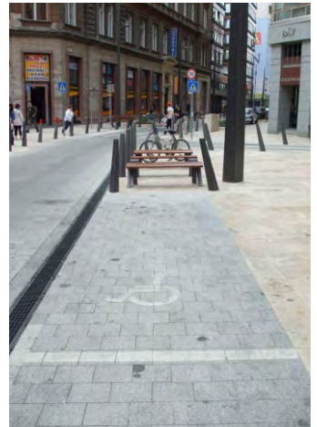
398-400. Pest új főutcájában a pollerek dőlési iránya esetleges (kivitelezési hiba), ami nehezíti a (párhuzamos) parkolást; fa takarja a táblát
