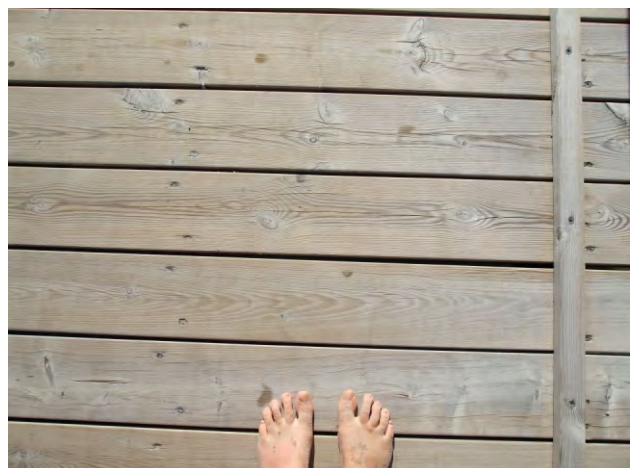
696-697. a kerekesszékkal való vízhez jutást segítő stég és rámpa kerékvetővel és korláttal ellátva; a hézagok keskenyek, megfelelőek
