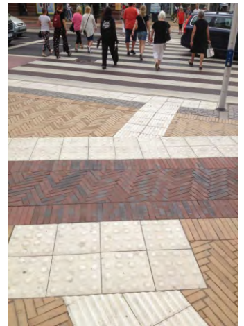
331-333. 2018-ra a figyelmeztetősávok lépéshossznyira szélesedtek; a vezetősáv olyan szélességű, hogy magán a jelzésen lehessen haladni
