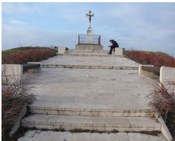
58-60. történelmi városközpont (esztétika), hiányzó kontrasztok és éljelölés (59-60. háromnál kevesebb fellépéseket is tartalmaz), korlát
