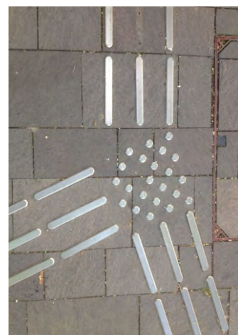
310-312. az utólag elhelyezett jelzésrendszer foghíjas, nincsen fenntartva; a csomópontokban ma már nem használatos a figyelmeztető jelzés
