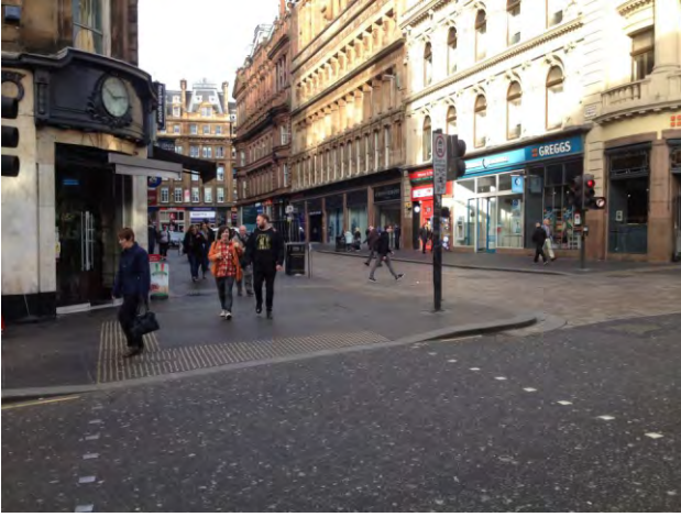
356-357. hazai tapasztalatok szerint a raszterben rakott figyelmeztetés mérsékeltlen alkalmas vezetésre, de emiatt figyelmeztetésre kevésbé
