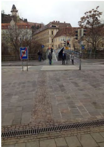
389-391. CWSM vezető- és figyelmeztetősáv teresedésről megtalálandó gyalogátkelőhöz
