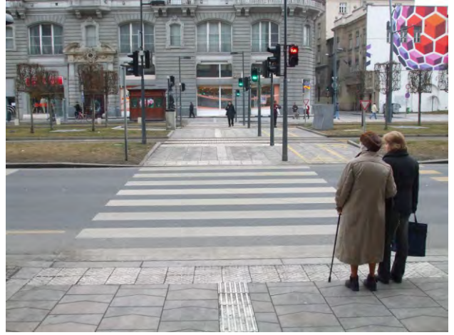
297-298. a kivitelezéskor nem fektették le a taktilis jelzésrendszert, hanem azt utólag kellett pótolni
