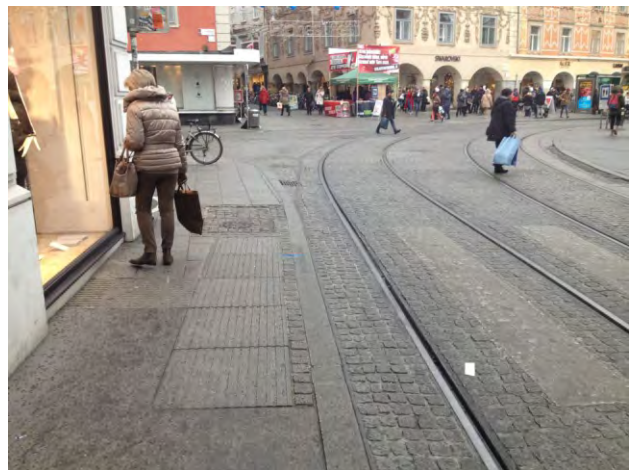
393. vezetőjelzés figyelmeztető funkcióban; szinkontraszt nincs
