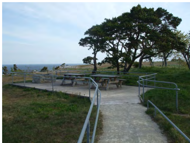
777-778. a korlát, ill. a kerékvetőként is szolgáló terelőlécc megakadályozza a látogatókat, hogy letaposják a védett terület növényzetét
