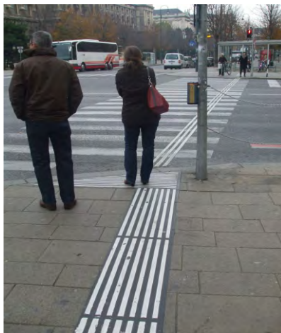
375-377. szinkontrasztos TWSI, csak vezetőelemekkel, az átvezetés magán az útpályán is adott (hazánkban ez nem terjedt el)
