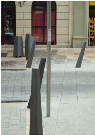
37-39. esetlegesen befördített, a gyalogossávba lógó, ferde pollerek, mögöttük a „Pöttyvándorlás” c. alkotás éles-sarkos üvegkubusai
