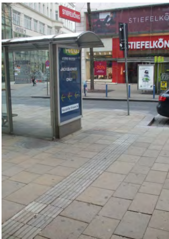
445-447. az első ajtó helye a burkolatban TWSI-vel jelezve; kerekesszékekkel is megközelíthető, és van elegendő hely a manőverezéshez
