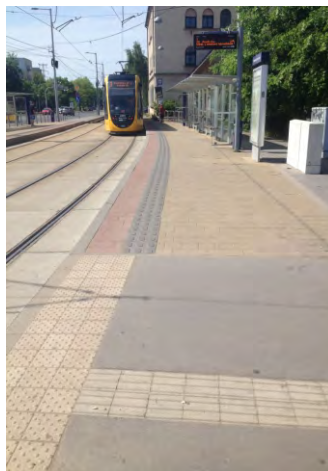
479-481. első ajtó és zónahatár jelölése az Ecseri úton; a villamosperon és a csatlakozó átkelőhely esetében is TWSI-rendszer telepített
