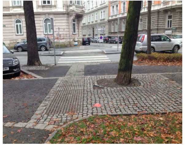
386-388. különböző burkolati arculatoknál ugyanazt a TWSI-rendszert alkalmazzák; keresztben álló vezetőjelzés figyelmeztető funkcióban
