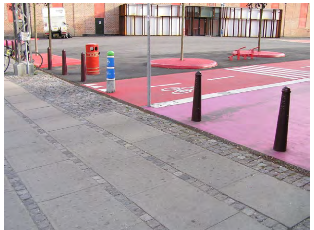
159-160. a járda és a teresédések zónáját eltérő burkolatminta jelöli (a járda következetesen ugyanolyan mintázatú)
