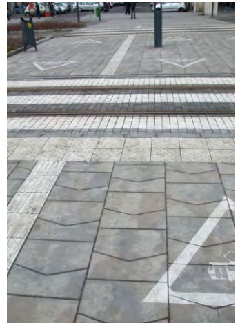
299-300. nem követték a terveket: a vezetősáv átkelőknél mindig figyelmeztetősávba fusson! magán az átkelőn hazánkban nincs vezetősáv
