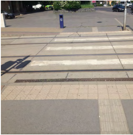
263-264. egy újabb magyarországi jelzésrendszer; az útburkolati jelek újrastendők 265. az átkelés tengelyére merőleges átvzetés
