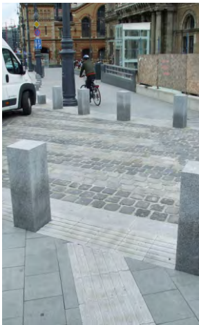
269-270. vezetőelemek cseréje figyelmeztetőelemekre
