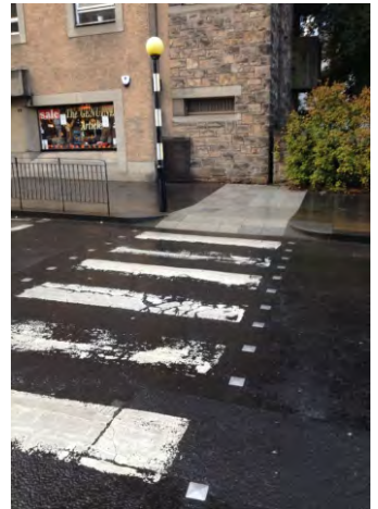
349-351. az átkelőhelyeket taktilis figyelmeztetősáv jelzi, rávezetés nincs, maga a szegélyrampa is taktilis burkolatú, amin nehezebb navigálni
