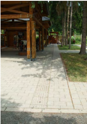
732-734. taktilis jelzés bemutatóközpont térköburkolatában: épületek környezetében a szilárd burkolat használata is indokolt lehet
