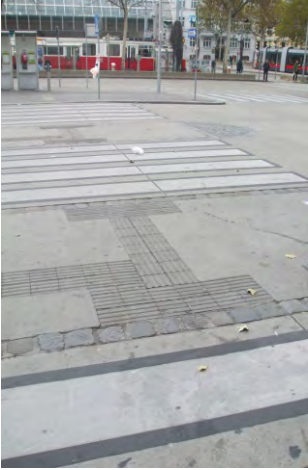
366-368. csekély szinkontrasztú TWSI Bécsben; figyelmeztetéskeresztbe fordított vezetőelemekkel
