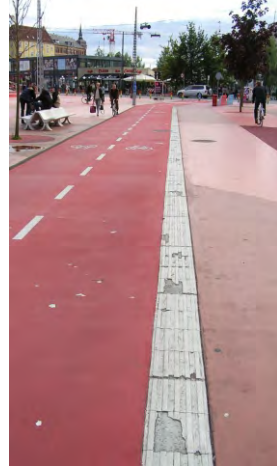
240-241. vezetősáv egyik oldala a kerékpárúton, ami nem biztonságos, hanem veszélyes útvonal!
