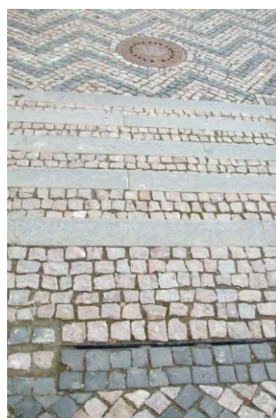
53-54. nem érzékelhető, balesetveszélyes lépcsős szegély / lépcső
