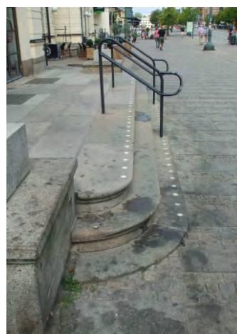
101-103. előlépcső és rámpa, a rámpa íves (kérdés: megfelelő-e a sugár-lejtés aránypár, vagy torzul a felület?), szíkontrasztos éljelölés
