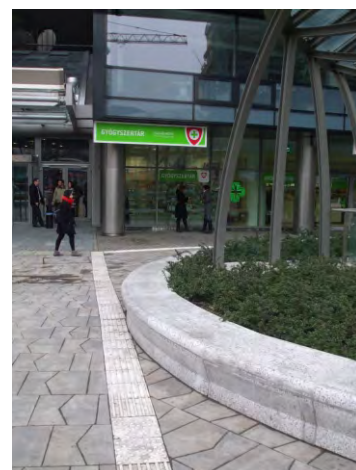
231-233. a kiskörűti egységes rendszerben elhelyezett vezetősávok a Kálvin téren; a vezetősáv mellett 80-80 cm-t szabadon kell hagyni
