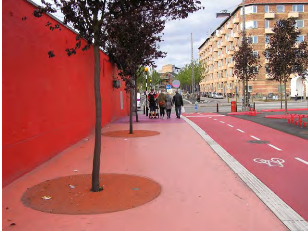
240-241. vezetősáv egyik oldala a kerékpárúton, ami nem biztonságos, hanem veszélyes útvonal!
