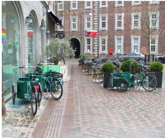
214-216. egyedi mesterséges taktilis jelzések egyedi terméskő burkolatban; mobil és rögzített akadályok a vezetősávon, fokozott veszély
