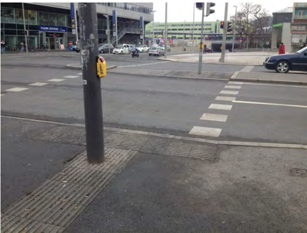
380-381. a vezetősáv közvetlenül objektumokra (jelzőlámpa, követhető lábazat) vezet rá, tehát azokat nem tekinti akadálynak...
