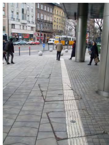
231-233. a kiskörűti egységes rendszerben elhelyezett vezetősávok a Kálvin téren; a vezetősáv mellett 80-80 cm-t szabadon kell hagyni
