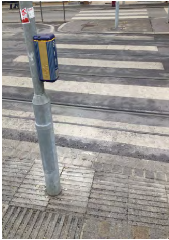
386-388. különböző burkolati arculatoknál ugyanazt a TWSI-rendszert alkalmazzák; keresztben álló vezetőjelzés figyelmeztető funkcióban
