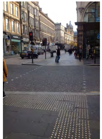
358-360. a rávezetés is figyelmeztetőelemekkel történik; az átkelést az útburkolaton nem jelölik, így hiányzik a vizuális kontraszt
