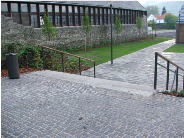
56-57. történelmi városközpont (esztétika), lépcsők két- és egyoldali, hasáb km. duplasoros kapaszkodóval, felül taktilis jelzés (keskeny)
