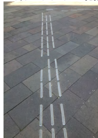
307-309. ...majd a rendszer átvált fémelemesbe, a Kossuth téri arculatnak megfelelően; a jelzésrendszer foghíjas, nincsen fenntartva
