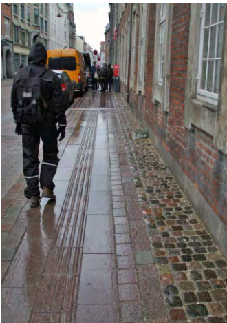
214-216. egyedi mesterséges taktilis jelzések egyedi terméskő burkolatban; mobil és rögzített akadályok a vezetősávon, fokozott veszély
