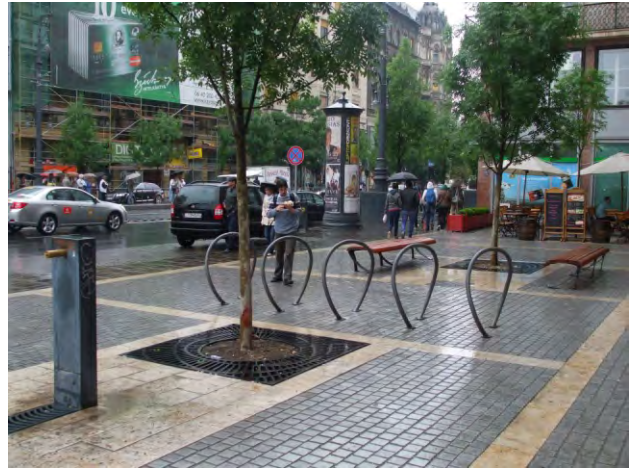
176-177. a megújításkor alkalmazott, kontrasztos-sávos burkolatminta önmagában alkalmas a funkciók jelzésére és az orientálásra
