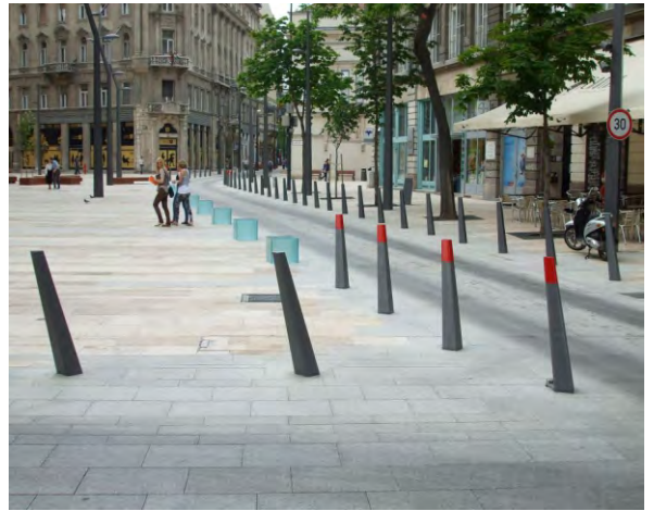
37-39. esetlegesen befördített, a gyalogossávba lógó, ferde pollerek, mögöttük a „Pöttyvándorlás” c. alkotás éles-sarkos üvegkubusai
