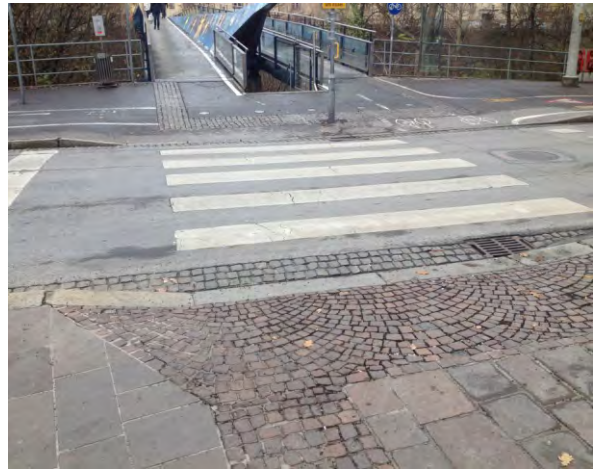
386-388. különböző burkolati arculatoknál ugyanazt a TWSI-rendszert alkalmazzák; keresztben álló vezetőjelzés figyelmeztető funkcióban
