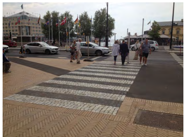
334-335. a megújított burkolat funkcionális jellegű: a különböző forgalmi sávok és funkciók vannak elkülönítve, konceptuális minta nincs
