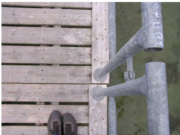
682-683. a kerekesszékkal való vízhez jutást segítő stég és rámpa; szezonon kívül nem szükséges a szigorú tisztán tartás
