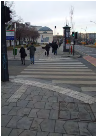
287-288. a rávezetés az átkelő tengelyével párhuzamos, és az átkelő két oldalán egymással szemben található
