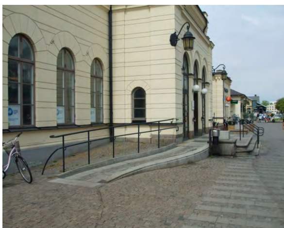
101-103. előlépcső és rámpa, a rámpa íves (kérdés: megfelelő-e a sugár-lejtés aránypár, vagy torzul a felület?), szíkontrasztos éljelölés
