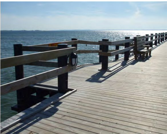
690-692. a kerekesszékkal való vízhez jutást segítő stég és rámpa
