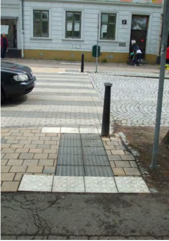
328-330. a figyelmeztetősáv az útburkolati jelekkel megegyező színű és szélességű; a vezetősáv csupán enyhe szinkontrasztot mutat
