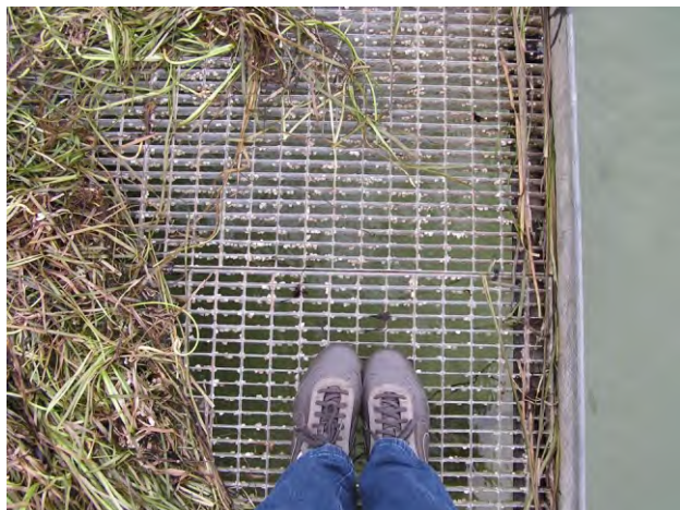
684. a kerekesszékkal való vízhez jutást segítő stég és rámpa
