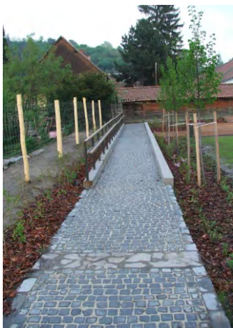
78-80. akadálymentes rámpa szolgál a lépcső (ld.56-57.) alternatívájaként, kerékvágyó és duplasoros korlát, amelyen a kéz nem akad meg
