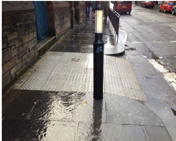
349-351. az átkelőhelyeket taktilis figyelmeztetősáv jelzi, rávezetés nincs, maga a szegélyrampa is taktilis burkolatú, amin nehezebb navigálni
