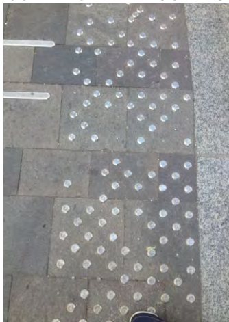
307-309. ...majd a rendszer átvált fémelemesbe, a Kossuth téri arculatnak megfelelően; a jelzésrendszer foghíjas, nincsen fenntartva
