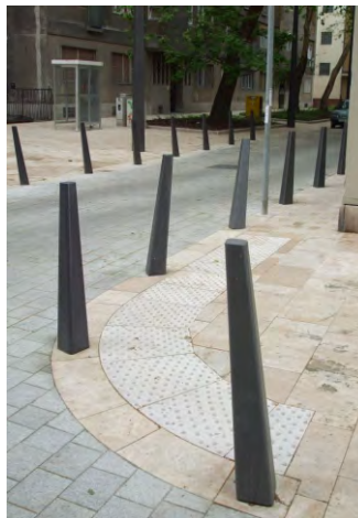
277-279. a figyelmeztetőelemek kialakítása lehetővé teszi az ívek kirakását; a ferde pollerek a közlekedés szelvényébe lógva veszélyesek
