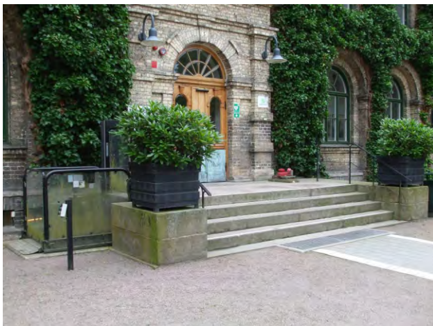
109. utólagos, környezetbe illesztett emelőlap egyetemi campuson
