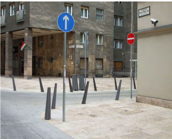
277-279. a figyelmeztetőelemek kialakítása lehetővé teszi az ívek kirakását; a ferde pollerek a közlekedés szelvényébe lógva veszélyesek
