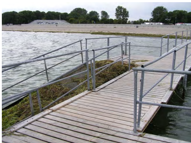
682-683. a kerekesszékkal való vízhez jutást segítő stég és rámpa; szezonon kívül nem szükséges a szigorú tisztán tartás
