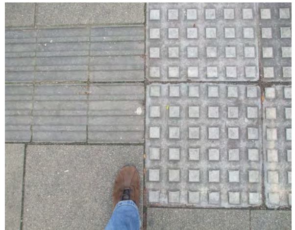
445-447. az első ajtó helye a burkolatban TWSI-vel jelezve; kerekesszékekkel is megközelíthető, és van elegendő hely a manőverezéshez
