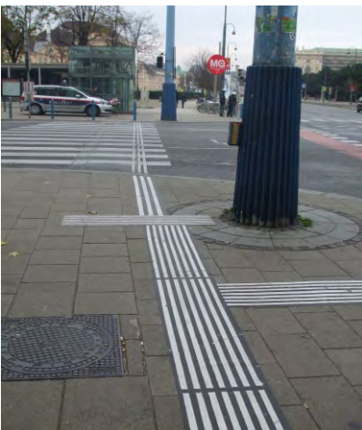
375-377. szinkontrasztos TWSI, csak vezetőelemekkel, az átvezetés magán az útpályán is adott (hazánkban ez nem terjedt el)
