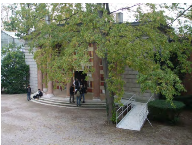
88-89. utólagos, mobil rámpával megoldott, az épület arcúthoz is illeszkedő akadálymentesítés
