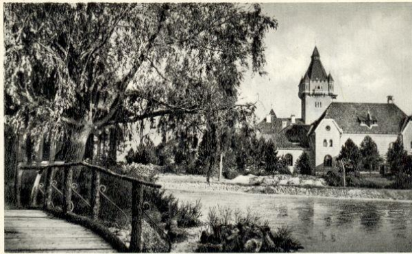
Hajmáskér. Parancsnoki épület tórészlettel 159. kép: A parancsnoki épület a kertből
