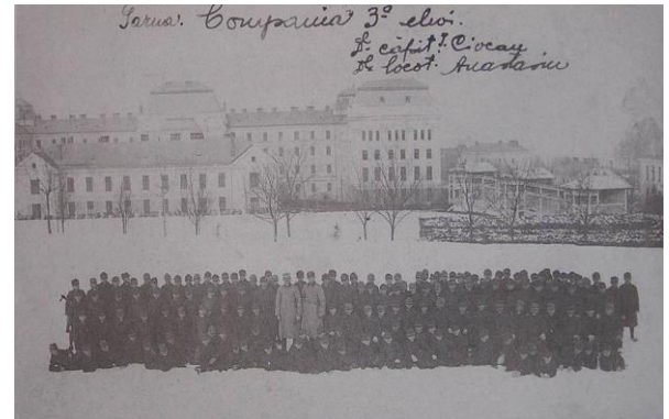
175. kép: Gyakorlótér az épület hátsó homlokzata előtt
