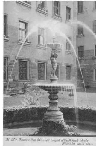
192. kép: Szökőkút a főépület utcai homlokzata előtt
