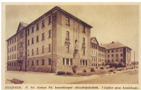
191. kép: A főépület utcai homlokzata
