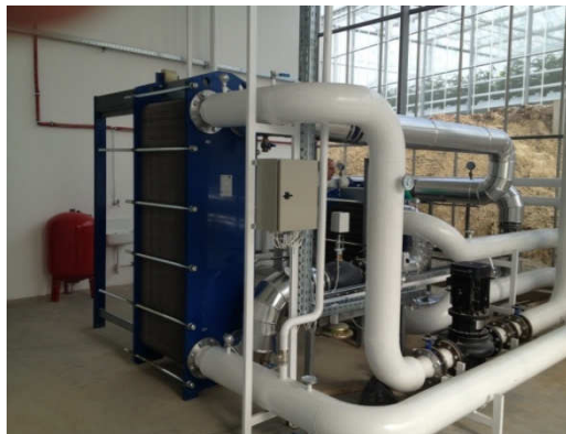
4.38. ábra A fűtési körnél alkalmazott lemezes hőcserélő
