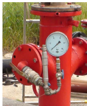
3.6. ábra Kútfej nyomásmérő
