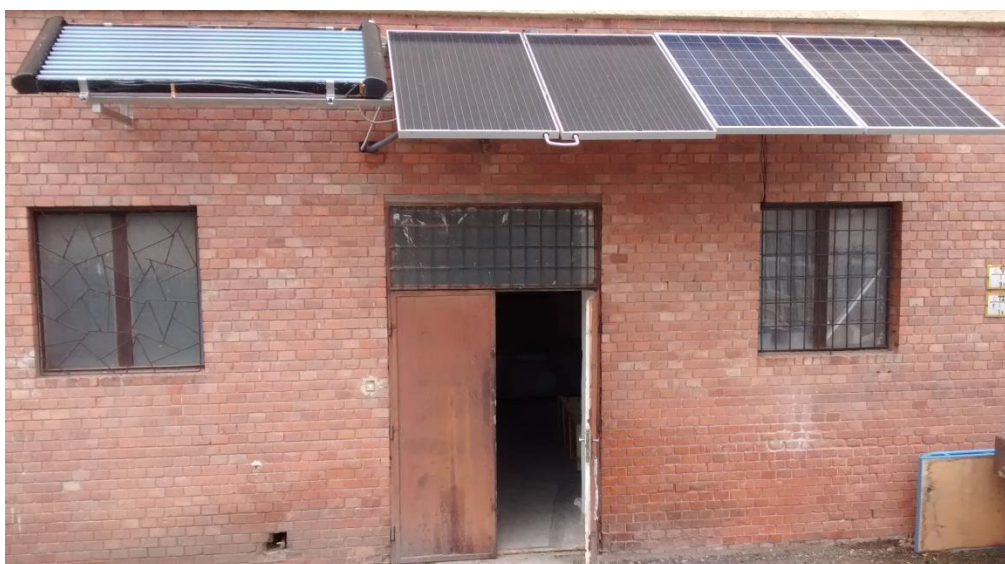
60. ábra. A mérési rendszer a PV/T kollektorokkal (középen), az UlicaSolar (jobbra) napelemekkel és a PCM kollektorral
