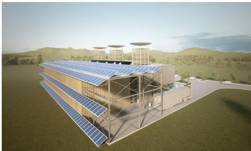
39. ábra. A referencia nullenergiás gyárépület látványterve a Venturi-tányérokkal és a napelemekkel
