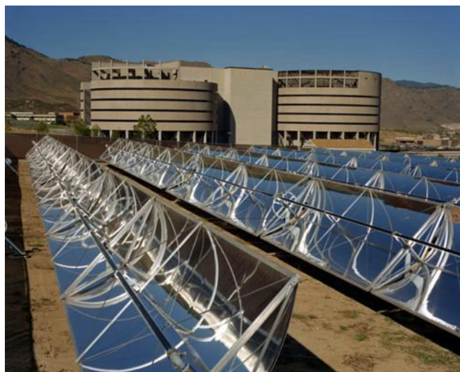
2.14. ábra Koncentrátoros kollektor ( http://www.ucsusa.org/clean_energy/ )
