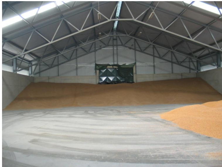
50. ábra Siktároló, betárolás teleszkópos rendszerrel történt.
