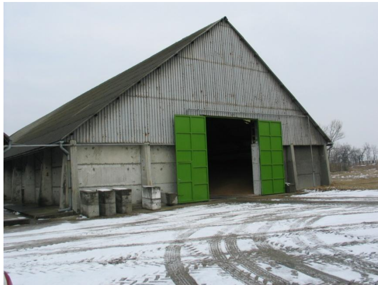
41. ábra 2000 t kapacitású gabonatároló (síktároló).
