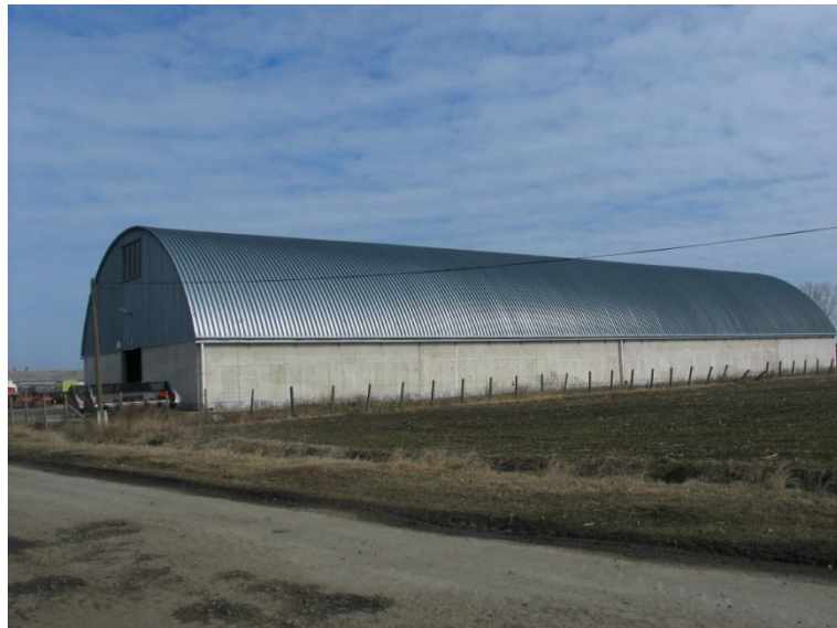
47. ábra Újépítésű síktároló (Tároló kapacitás 5000 t.).
