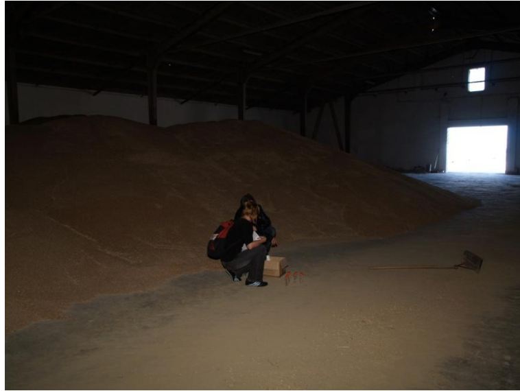
51. ábra 6000 tonnás tárolókapacitású síktároló.
