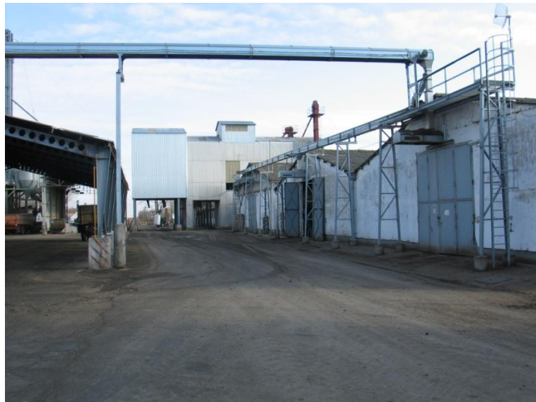
45. ábra Jászapáti második helyszín: siktároló felső betároló rendszerrel.
