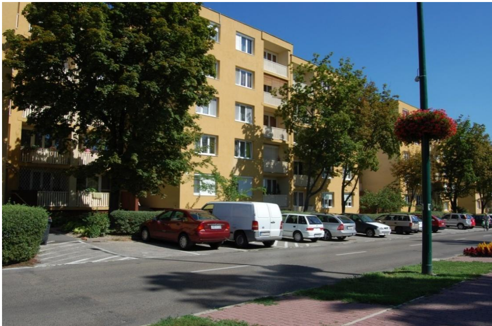
10. sz. kép: Felújított lakótelep Forrás: Laki Ildikó Százhalombattai fényképek 2012
