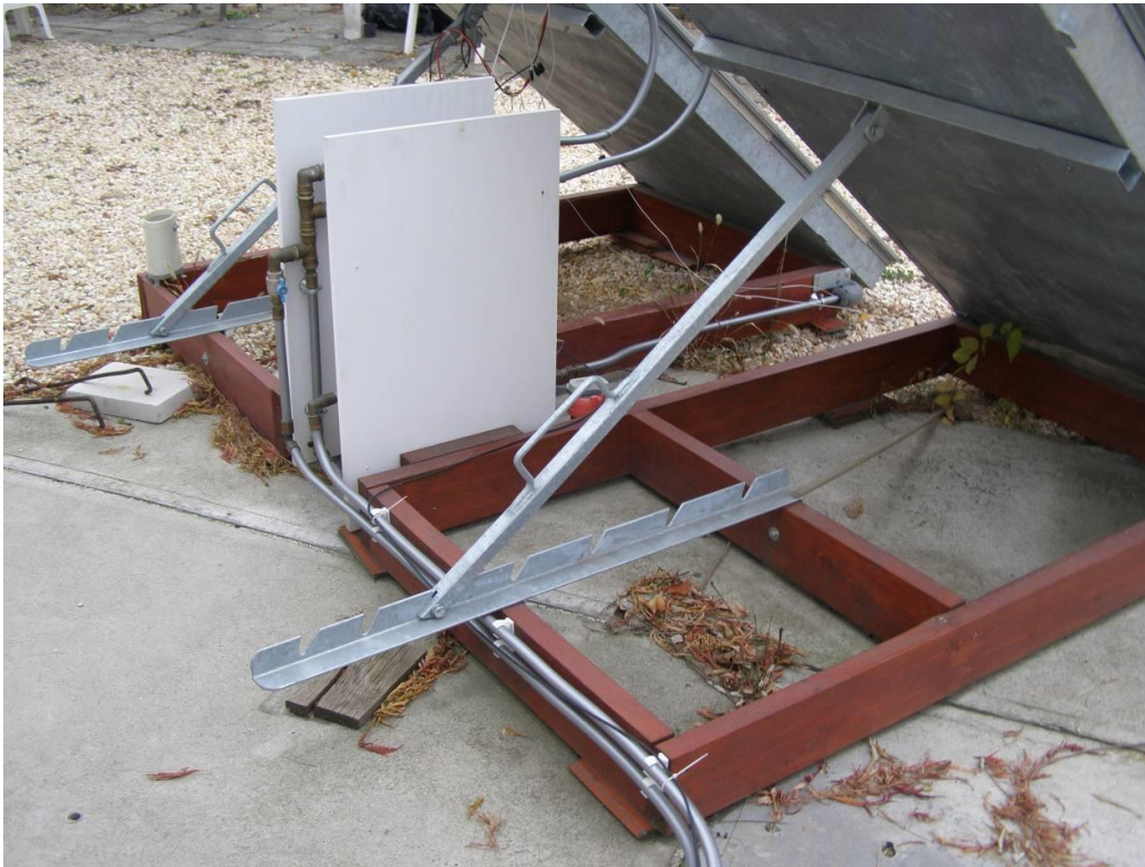
3.7. ábra: Dönthető kollektorállványok
