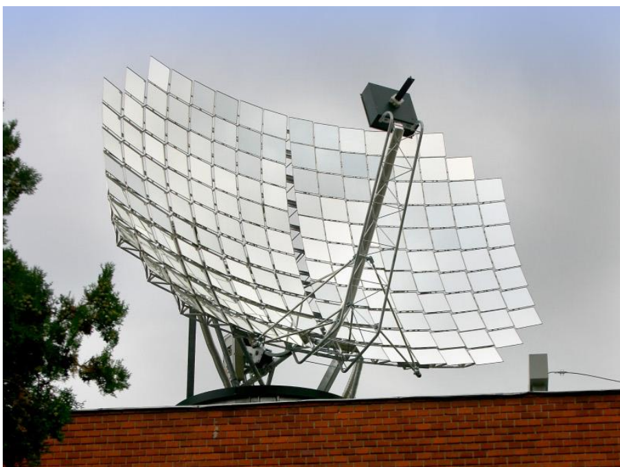
2.4. ábra: A Magyar Villamos Művek Zrt. 10 kW-os, parabolatányéros kollektora Csepelen ( http://csepel.info/?p=6296 - 2012.01.20.)
