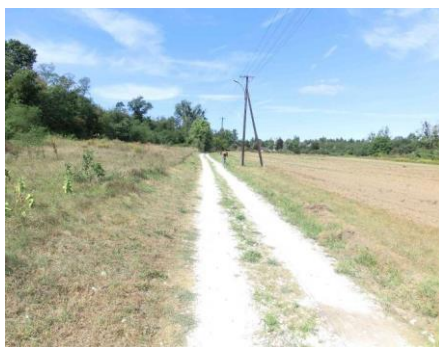
3.35. ábra: Zúzott kővel kevert murvás útszakasz
